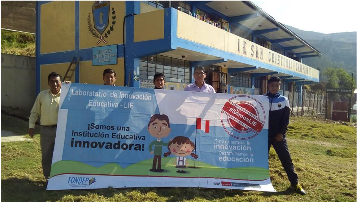
Ilustración 1. FACHADA PRINCIPAL DE LA INSTITUCION EDUCATIVA
